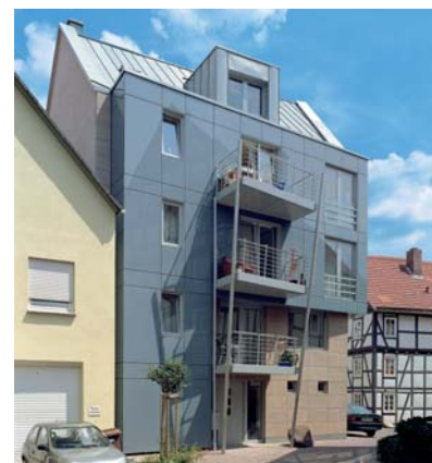
StoVerotec Fassade. (Obytný dům, D)
