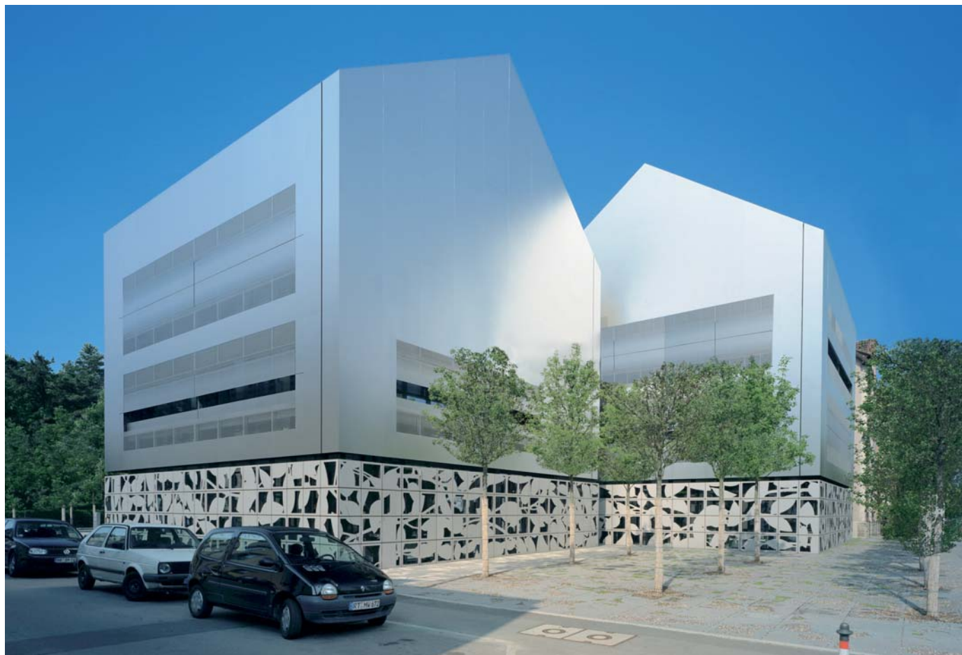
Orientované do budoucna a efektivní: na futuristické fasádě není poznat zateplovací systém StoTherm Mineral s deskami z minerální vlny. (Südwestmetall Reutlingen, D)
