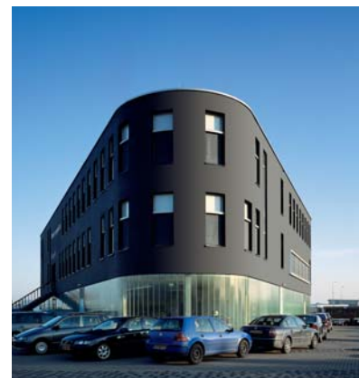
StoVentec Fassade. (KLPD Policejní prezidium, NL)
