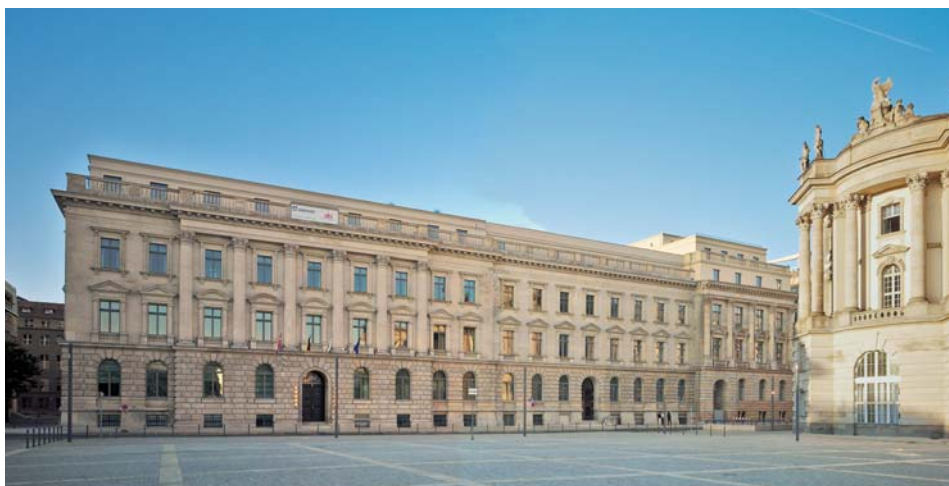
Úprava se Stoplex W vyrovnává nasákavost podkladu a dodává fasádám stabilní a odolný základ. ( Opern Carrée, D )
