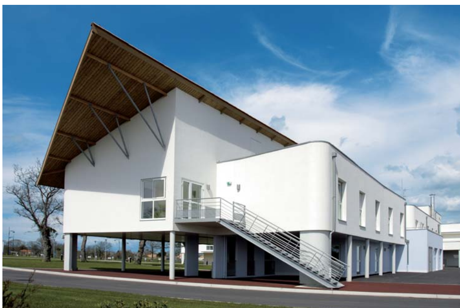
Úpravou podkladu se reguluje nasákavost fasády, která je pak obzvláště vhodná pro následnou povrchovou úpravu. ( Hospital Intercommunal du Pays de Retz, F )
