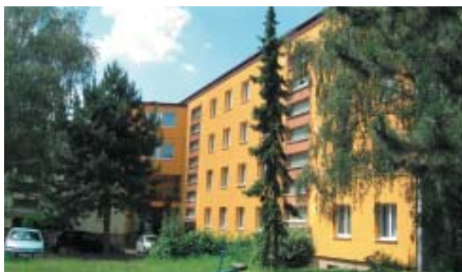
Panelový dům Klecany
