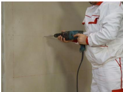
Obr. 34 – Vrtání otvorů pro kotvy
