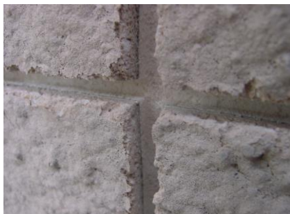
Obr. 50 – Vyfrézované drážky
