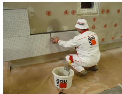
Obr. 38 – Lepení tepelně izolační desky
