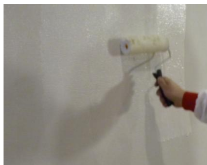
Obr. 32 – Provádění základního nátěru
