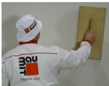
Obr. 31 – Broušení základní vrstvy
