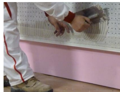
Obr. 14 – Okapnička k soklovému profilu ETICS
