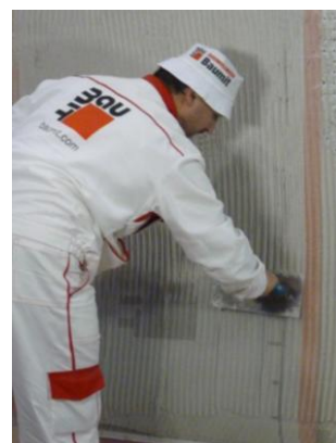
Obr. 30 – Uložení sklotextilní síťoviny
