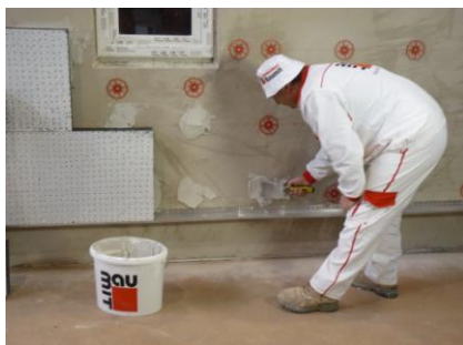
Obr. 36 – Nanášení lepidla na kotvy StarTrack
