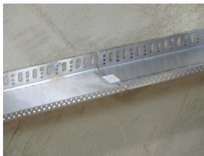
Obr. 13 – Spojka soklových lišt PV 30
