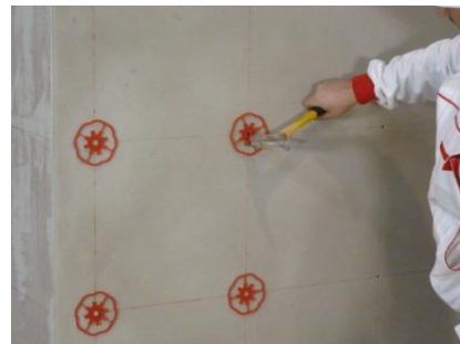
Obr. 35 – Aktivace kotvy StarTrack red
