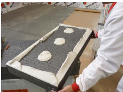
Obr. 37 – Nanášení lepidla na tepelně izolační desku
